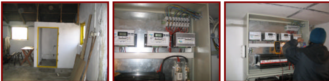
Az inverterkamra és a szerelési munkálatok
