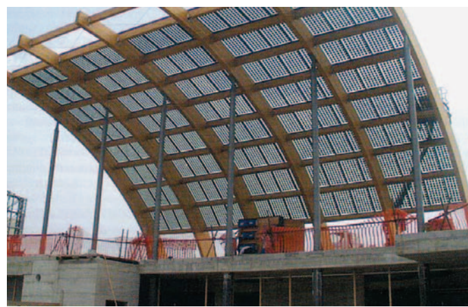
Transzparens napelemmel borított épülő házrészlet
