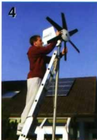
4. kép Családi ház energiaellátása – építési munkák: nap-szél hibrid
